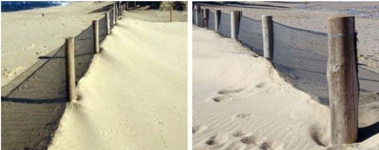
Fig. 4.9. Pantallas de malla sintética tipo "SOMBRITE" donde comienza a observarse la acumulación de arenas a sotavento de las mismas.
