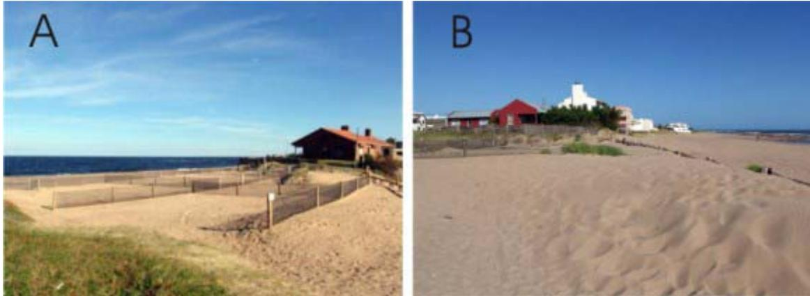
**Fig. 4.6.** Pantallas de malla sintética con disposición cruzada para optimizar la deposición de arenas en La Balconada (La Paloma), en (A) al inicio de las obras, en (B) luego de unos meses con tres eventos de vientos del sector Sur de c.a 60 km/h. Nótese la acumulación de arenas con una altura incrementada en c.a 1m en las primeras pantallas. La imagen está tomada del sector opuesto a la anterior. Proyecto realizado a través de la ONG SOS, La Paloma, Rocha, 2007.
