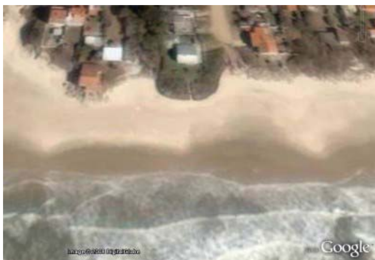
Figura A. Se observan los impactos de la construcción de muros de concreto y taludes de grandes bloques de piedra. La acción del oleaje genera pequeños arcos de playa a cada lado de las estructuras, lo que significa un retroceso de la playa y la afectación de las construcciones a ambos lados. Con el tiempo el oleaje remueve las arenas por detrás de las estructuras haciendo que éstas colapsen o necesiten reparaciones o más piedras, pero la erosión continúa hasta que se alcance un nuevo estado de equilibrio dinámico en toda la extensión de la playa. Costa Azul, Rocha.
